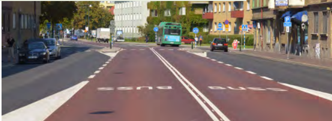
Malmöexpressen – busskörfält i mitten av gatan utan avgränsning och med röd asfalt och målning som visar att det är busskörfält.
