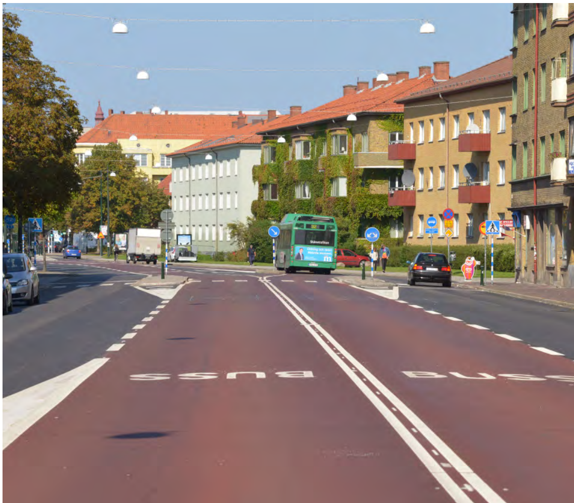
Malmöexpressen – busskörfält där röd asfalt visar att det är busskörfält.
