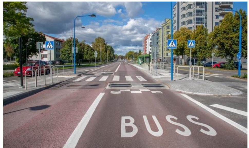
Figur 4 Mittförlagda busskörfält och hållplats med bussvänligt farthinder. Foto: Fredrik Kellén
